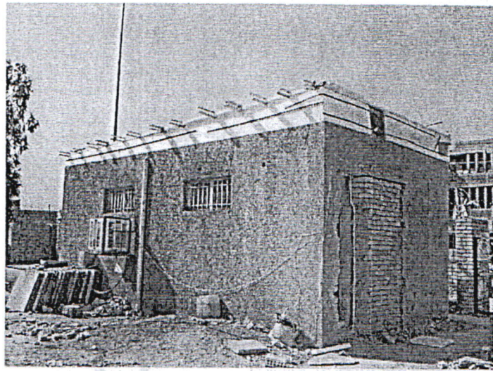
الشكل 7 غرفة التجارب. حجرة تبريد السطح فوق المبنى والمبردة على اليسار لتبريد الجدار. يمكن رؤية الفراغ بين الجدارين قرب الباب حيث يخرج الهواء بعد تبريد فراغ الجدار [7]
