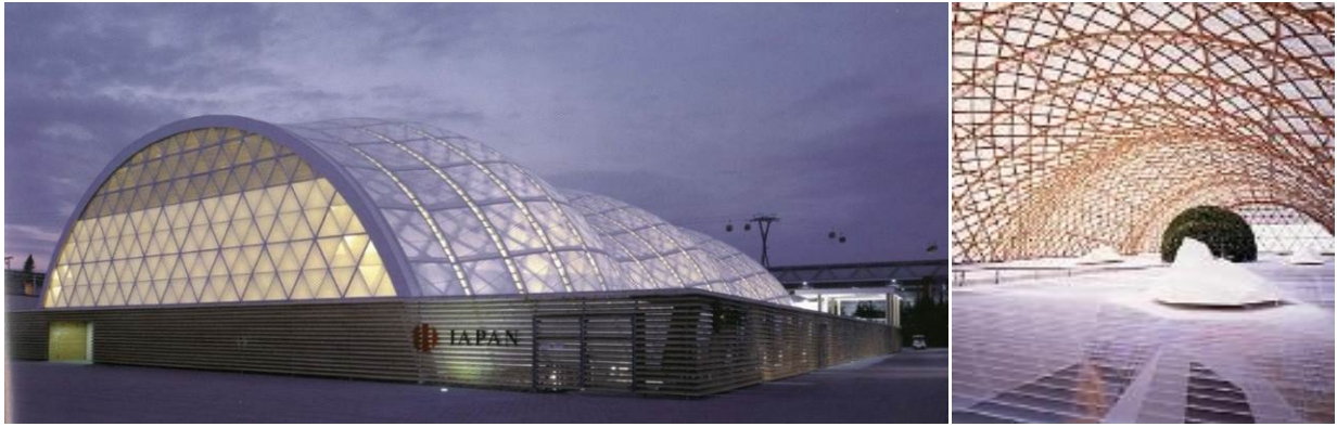
شكل(4): منظر داخلي واخر خارجي للجناح الياباني يظهر شفافية الغلاف الخارجي والهيكـل الداخلي/ المصدر: [Verlag_A.,83]
